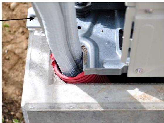
8. Zunanjo enoto je potrebno s štirimi vijaki ustrezno namestiti na podstavek. Potem zasujte podstavek z zemljino (do višine 5cm pod zgornji rob podstavka). Neuporabljene odprtine na betonskem podstavku je potrebno po zaključeni montaži zapreti.
