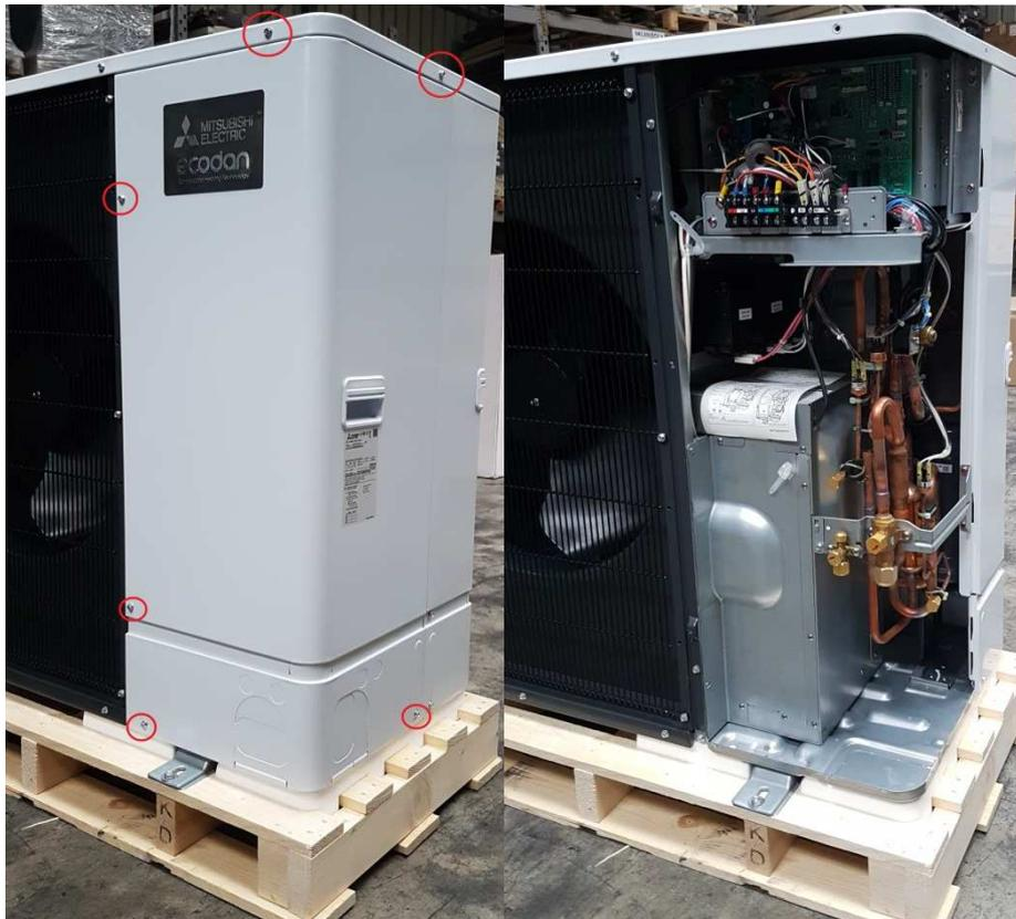
2.) Kompressor je zaščiten z dodatnim pločevinastim ohišjem. Le-tega je potrebno odstraniti, kot prikazuje slika:
