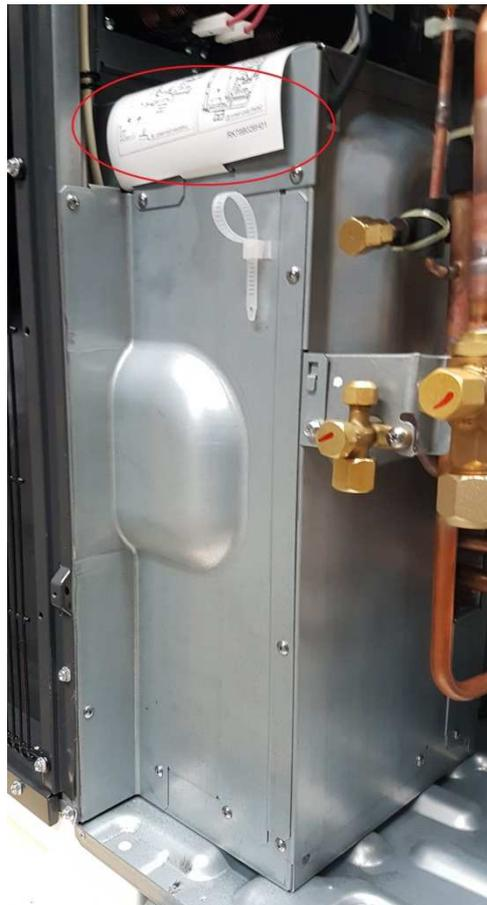
Pod zunanji zaščitni stranicami se prav tako nahajajo navodila za odstranitev transportnih zaščit. Ko ste odstranili vse transportne zaščite ter navodila, namestite nazaj pločevino od dodatnega pločevinastega ohišja kompresorja ter obe zunanji zaščitni pločevini.
